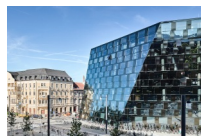
Universitätsbibliothek, Freiburg Degelo Architekten
